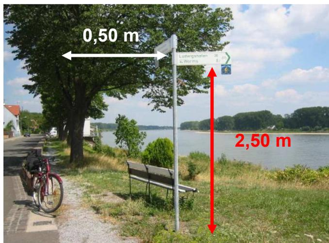
Abbildung 7-8 Bei zu geringem lichten Raum können Pfeilwegweiser ausnahmsweise mit dem Pfeil zum Mast montiert werden.
