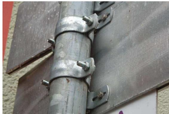
Abbildung 7-6 Pfeilwegweiser mit Stahlbandschellen befestigt
